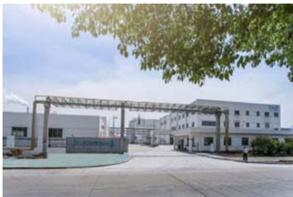
花王（上海）化工有限公司新工厂外观
